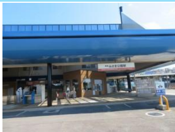
No5. みさき公園駅 20250907（日）13:32
