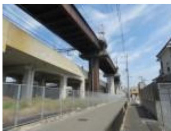
泉佐野駅への路 空港線の線路
