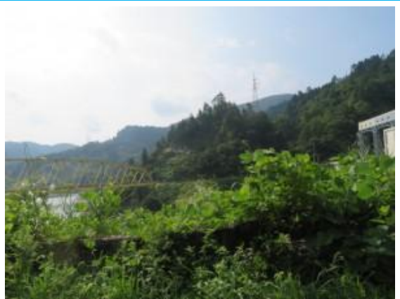
第六只見川橋梁 20250827（水）9:11
