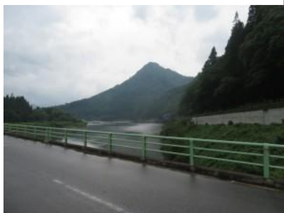
第八只見川橋梁 20250827（水）14:17
