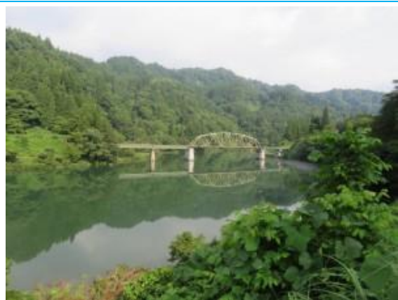
第五只見川橋梁 20250827（水）8:29
