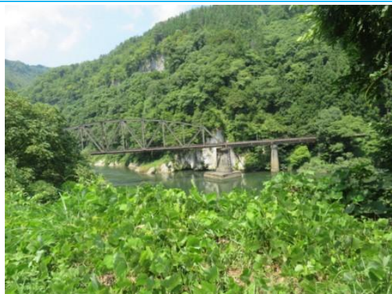
第四只見川橋梁 20250826（火）12:25
