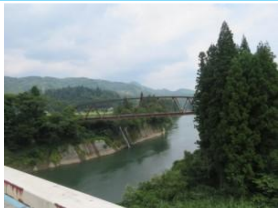
第七只見川橋梁 20250827（水）11:50
