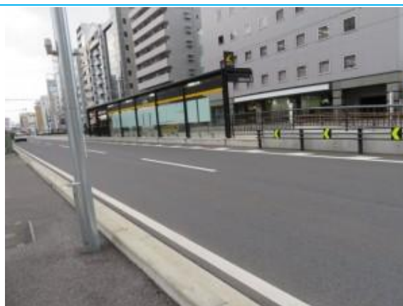
No27. 駅東公園前駅 20250410 (木) 16:40
