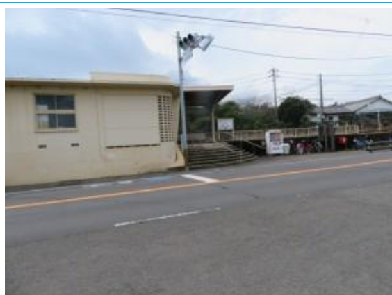
No7. 子供の国駅 20240222（木） 12:41
