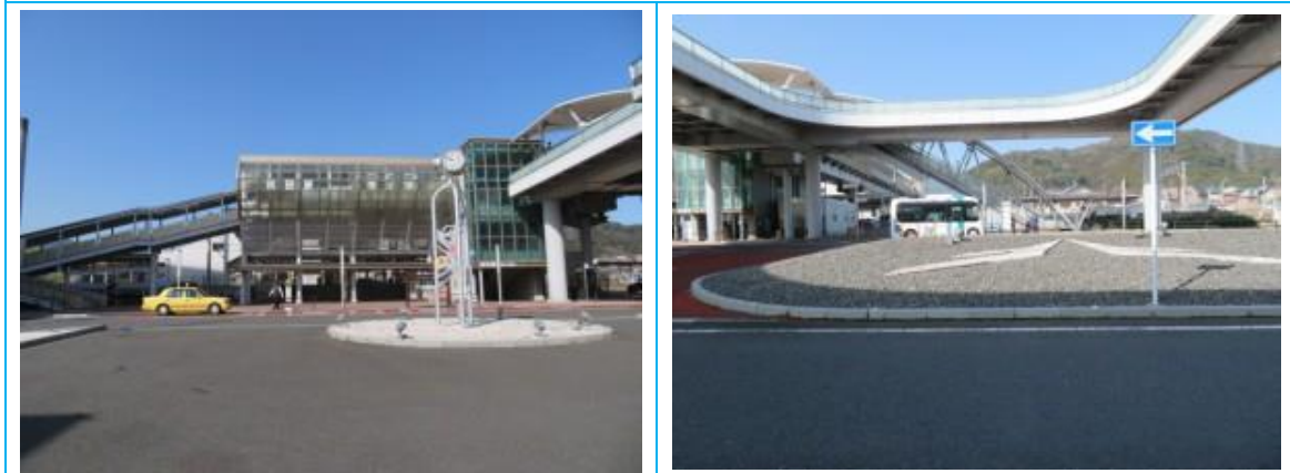
No8. 苅田駅 (かんだ) 20220316 (水) 9:50
