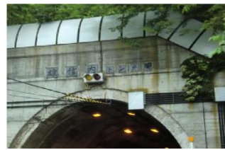
雄信内トンネル
