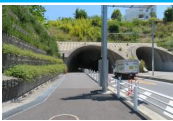
岸谷生麦トンネル
