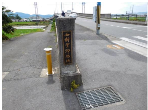
西新堂跨線橋
