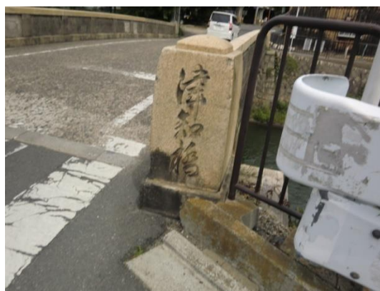
津和橋 (伏見駅への路)
