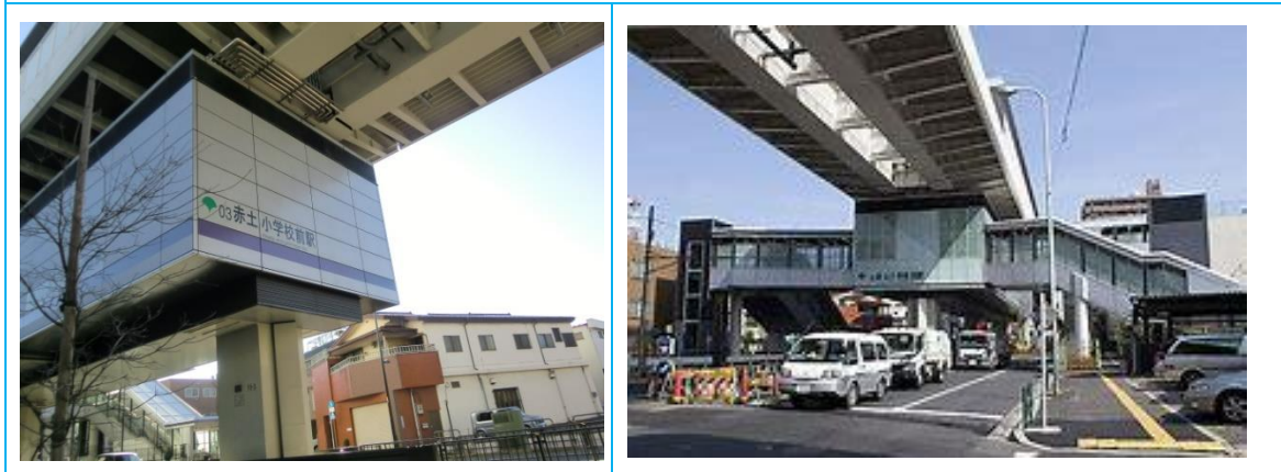
No30. 赤土小学校前駅 20130216（土）15:08
