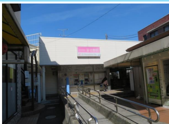
No89. 習志野駅 20061223 (土) 13:05
