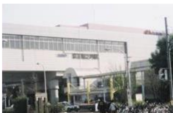
No50. 京王堀之内駅 20050409 (土) 15:52
