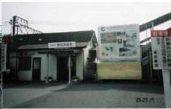
No86. 東武金崎駅 20050717 (日) 15:35
