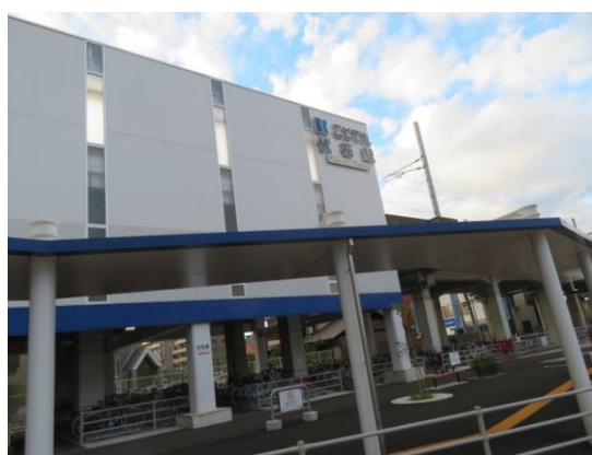
No6. 伏石駅 (新設) 20070822 (水) 20221018 (火) 16:44
