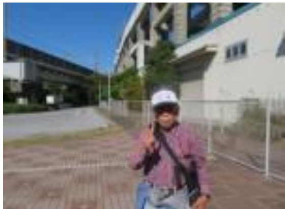
二俣支線と高谷支線の合流点
