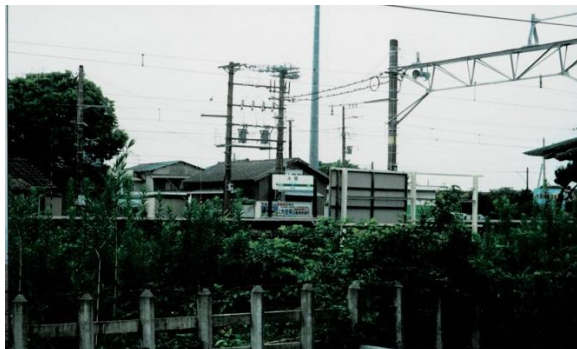
No12. 大貫駅 20010811(土)
