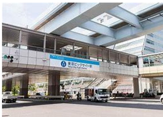
No11. 東京ビッグサイト駅 20120929 (土) ネットより
