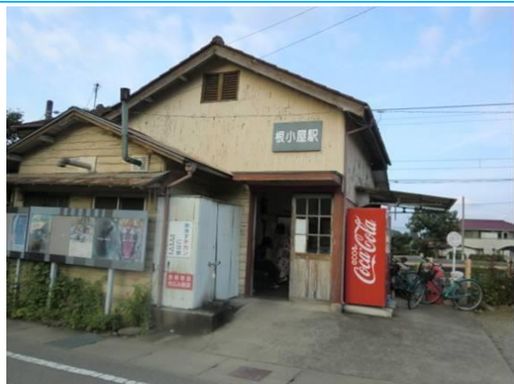
No64. 根小屋駅 20110827 (土) 17:00
