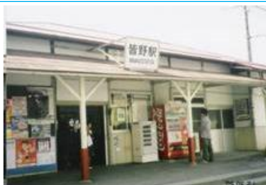
No27. 皆野駅 20050521 (土) 13:405
