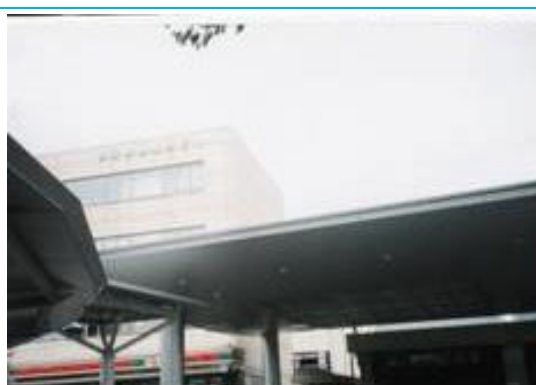
No9. 熊谷駅 20050514 (土) 13:00
