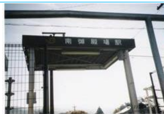
No53. 南御殿場駅 20051126(土)8:53
