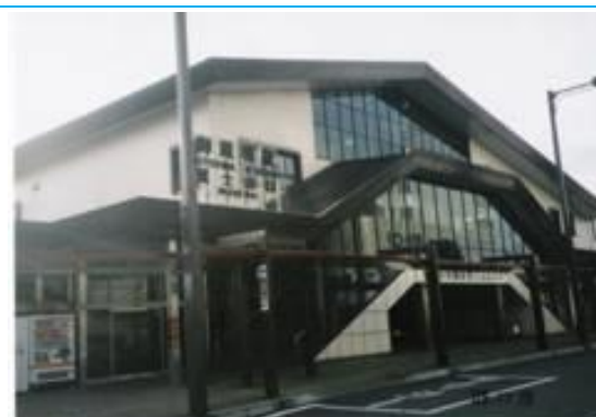
No52. 御殿場駅 20051119(土)7:56 20051126(土)7:56
