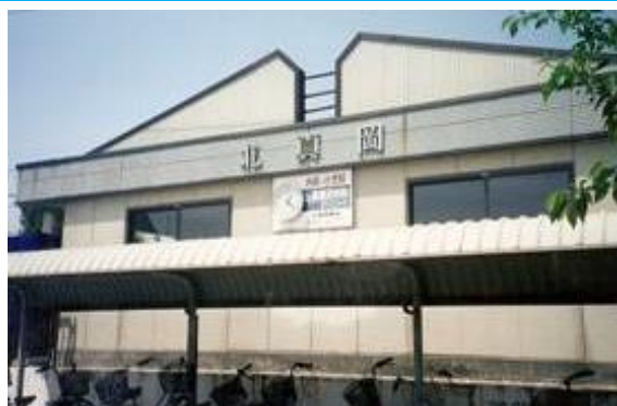
No62. 北真岡駅 20070505（土）12:22
