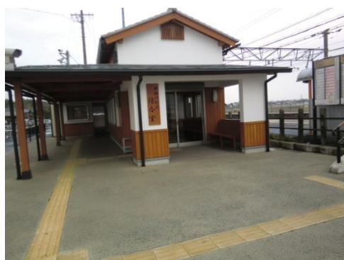
No17. 井田川駅 20130310 (日) 16:08
