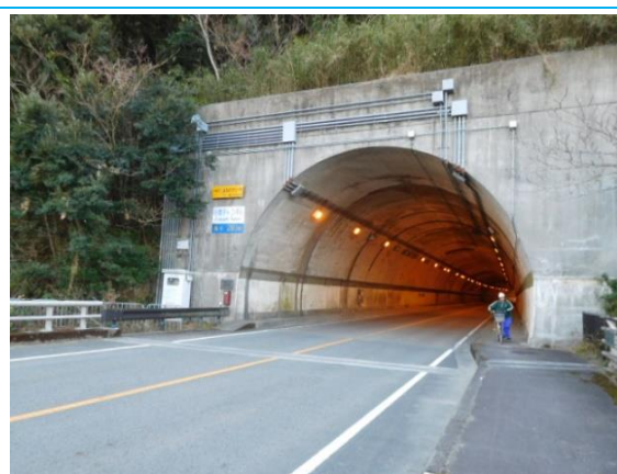
小犬トンネル
