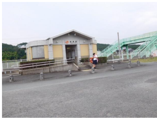
No13. 栃原駅 20150808 (土) 17:06 20150809 (日) 9:05
