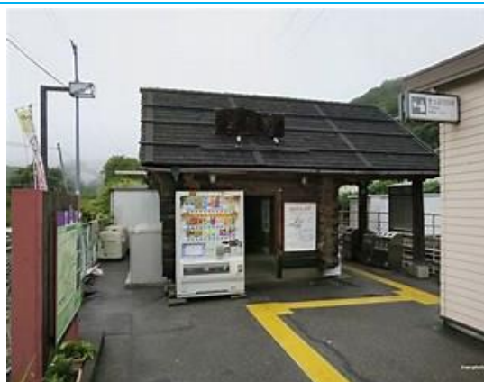
No14. 梁川駅 (やながわ) 20060617 (土) 11:08
