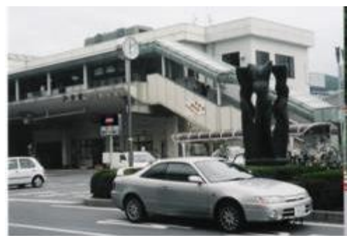
No41. 茅野駅 (ちの) 20060923 (土) 11:45
