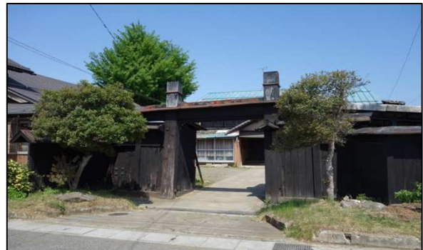
稲荷山宿本陣 この本陣はめずらしく街道に面していない
