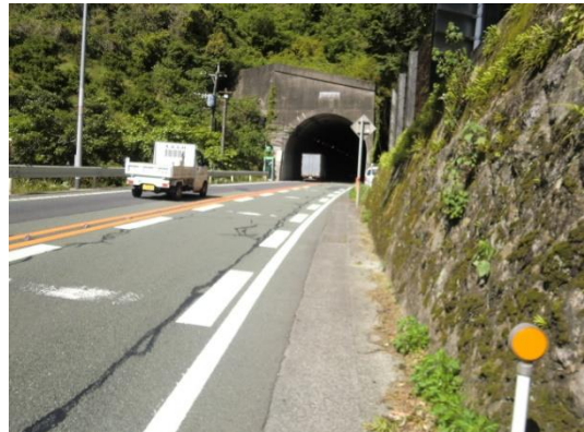
佐敷トンネル (佐敷駅への路)
