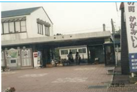
No249. 須賀川駅 20090809（日）17:40
