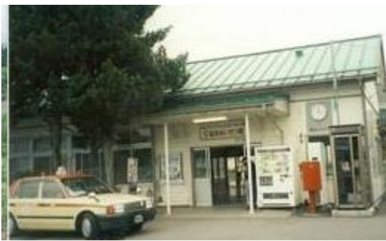
No240. 松川駅 20090802(日)12:15
