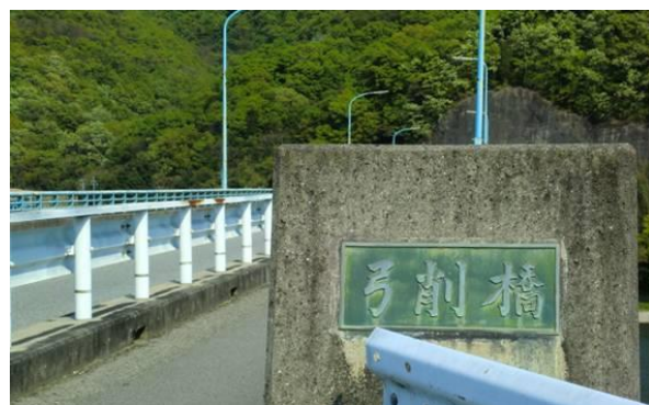
弓削橋 (万富駅への路)
